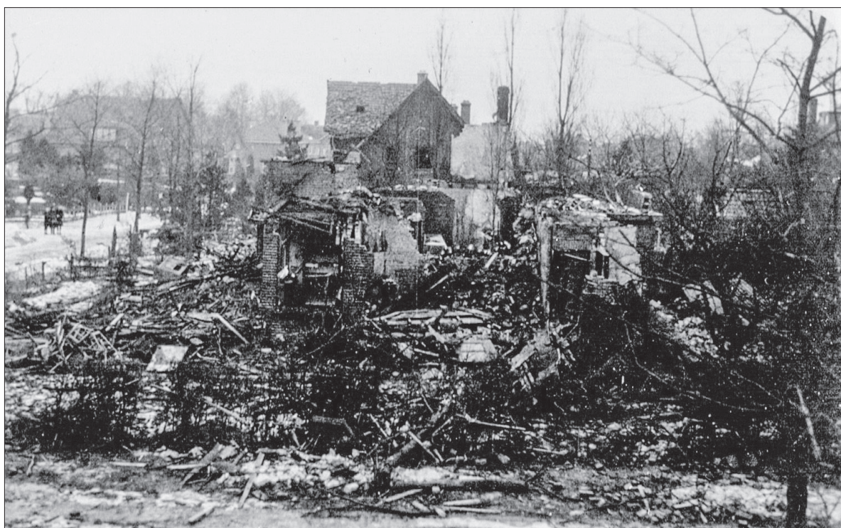
Van de getroffen huizen aan de Talmalaan bleef nauwelijks iets overeind.
