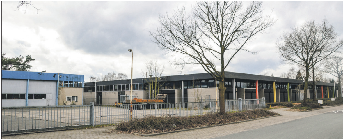
● De gemeente heeft de panden van Hypsos en Kiek aan de Batenburgweg aangekocht die na de sloop plaatsmaken voor woningbouw.
