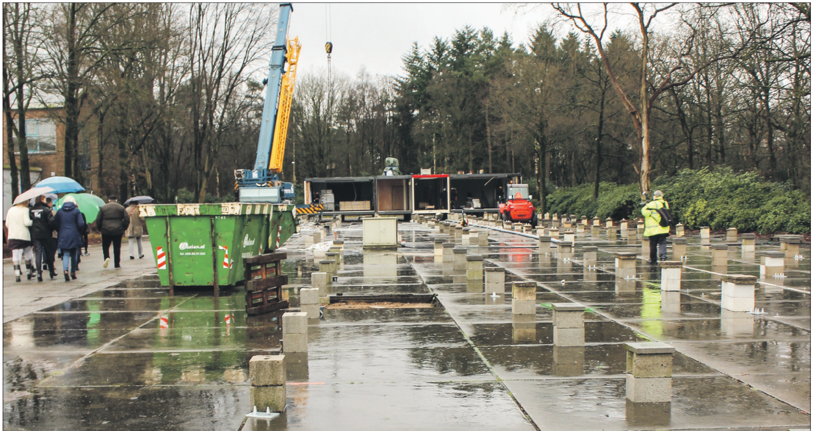
• De bouwplaats voor de woonunits op het voormalige museumterrein aan de grens tussen Zeist en Soesterberg.
