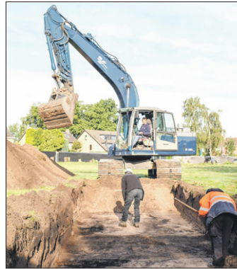
Graafmachines verwijderen de bovenste laag grond (0,5 tot 1,5 meter).
