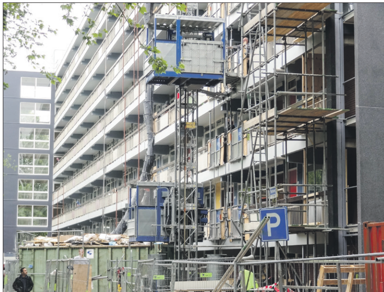
● Werkzaamheden aan de 7-hoogflat aan de Smitsweg (lage nummers).
