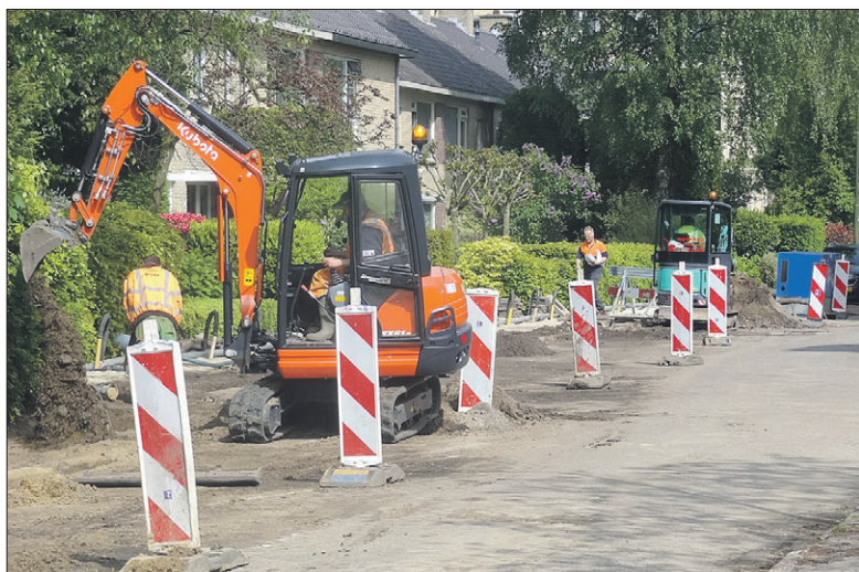
• Vooralsnog alleen werk aan gas- en waterleidingen. Foto: Soester Courant
