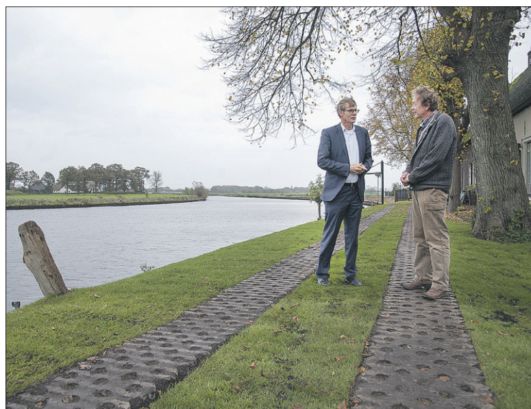
Eind vorig jaar was de afronding van de verhoging en versterking van de dijken langs de Eem. Ook in Soest, zoals hier bij de Kleine Melm. Het Waterschap liet het project uitvoeren. Foto: Ronald Kersten
