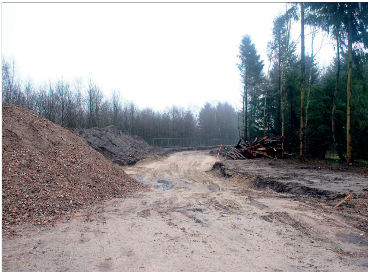
● De oostelijke ontsluitingsweg gaat bij de Veldmaarschalk Montgomeryweg over op de Batenburgweg. Een aansluiting met de vliegbasis anders dan het fietspad komt er niet. Foto: Eempers
