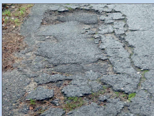
Gaten, kuilen, hobbels, gleuven, scheuren. De rijbaan van de Wieksloterweg oogt als een lapjesdeken.
