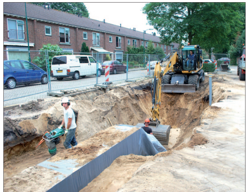
● De parkeerplaatsen langs de Christiaan Huygenslaan in Soesterberg, ter hoogte van De Linde en de Carolusschool, zijn weer beschikbaar nadat ze een tijd niet gebruikt konden worden. Dat was het geval tijdens rioleringswerkzaamheden. Een deel van het ondergrondse afvoersysteem moest worden vernieuwd omdat het oude riool tijdens hevige regenval het water niet meer voldoende kon afvoeren. De werkzaamheden zijn nu afgerond. Foto: Eempers
