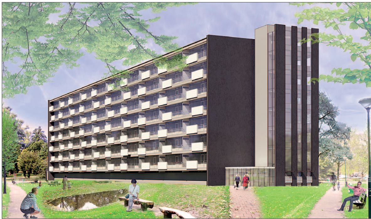
● Artist impression van hoe de twee zevenhoogflats aan de Smitsweg er uit gaan zien. Aan weerszijden komt er een lift, zodat beide complexen in het Smitsveen voortaan drie entrees hebben. Bron: Portaal
