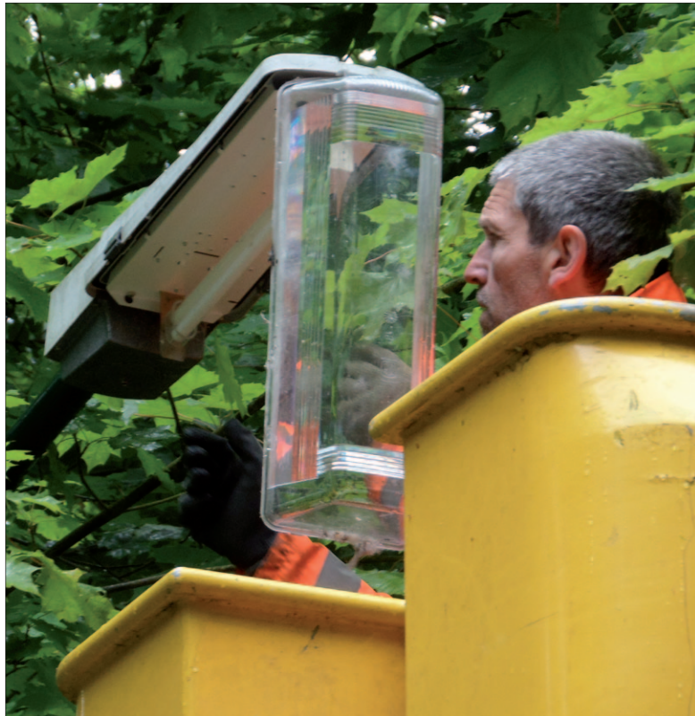
• Kap omlaag, buizen vervangen en kap weer omhoog. Foto: Soester Courant
