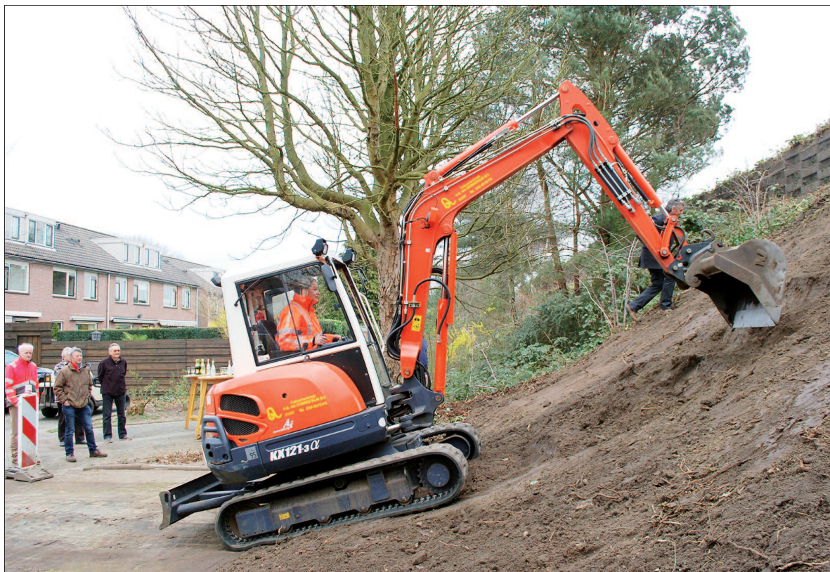
● Met behulp van een graafmachine egaliseerde wethouder Van Berkel de werktrap op de geluidswal.
