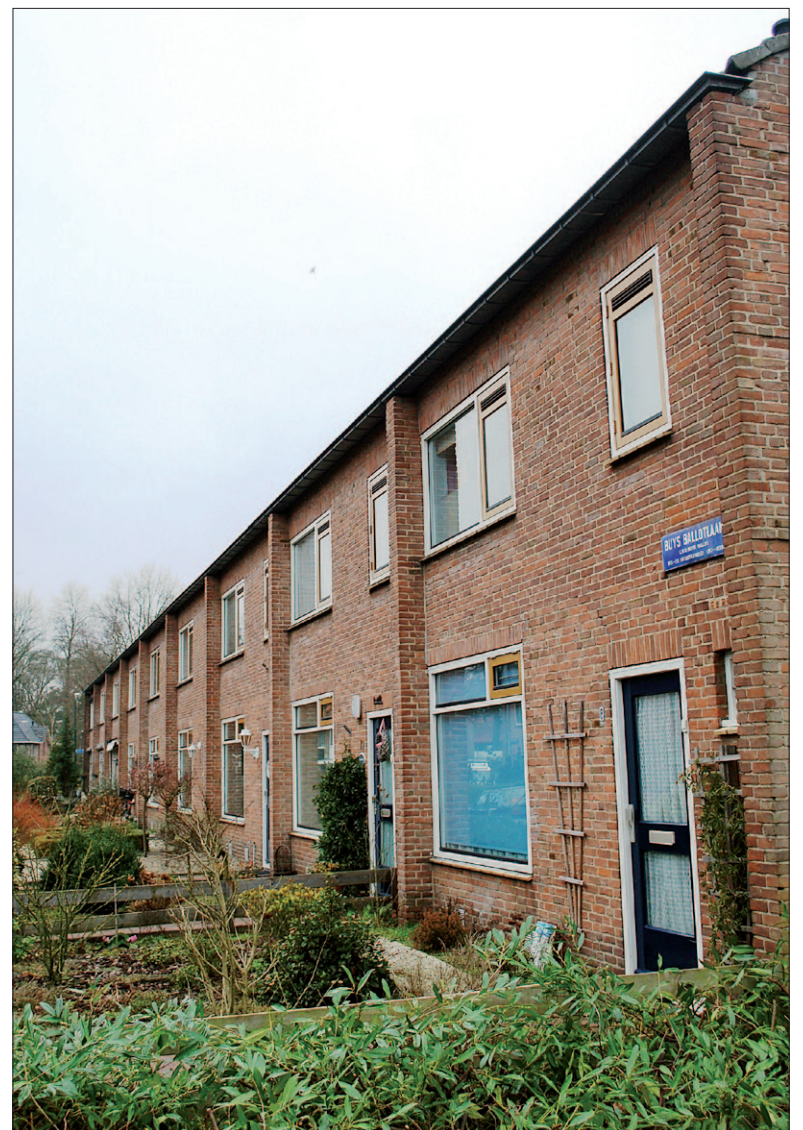
● Ook deze rijtjeshuizen aan de Buys Ballotlaan worden door Portaal voorzien van een 'warme jas'. In totaal wil de corporatie 109 eengezinswoningen isoleren en energiezuinig maken. Foto: Eempers
