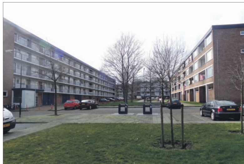
• De Eng is een van de drie wijken/kernen waar Portaal huurwoningen wil gaan renoveren. Er wordt in het najaar mee begonnen. Foto: Soester Courant
