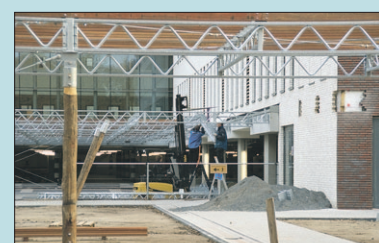
Technische specialisten zijn buiten aan het werk.
