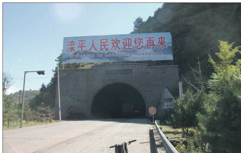
• De tunnels in China zijn een ellende.
