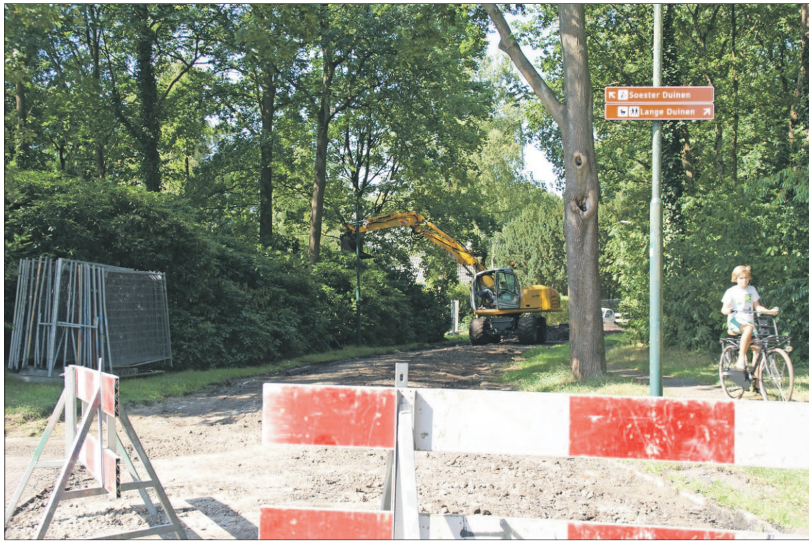
● De eerste werkzaamheden in de omgeving van de Heideweg zijn begonnen. Auto's kunnen over een deel van de Heideweg niet meer rijden. Fietsen gaat nog net. Het voornaamste doel van de herinrichting is om de verkeerssituatie in het gebied te verbeteren.
