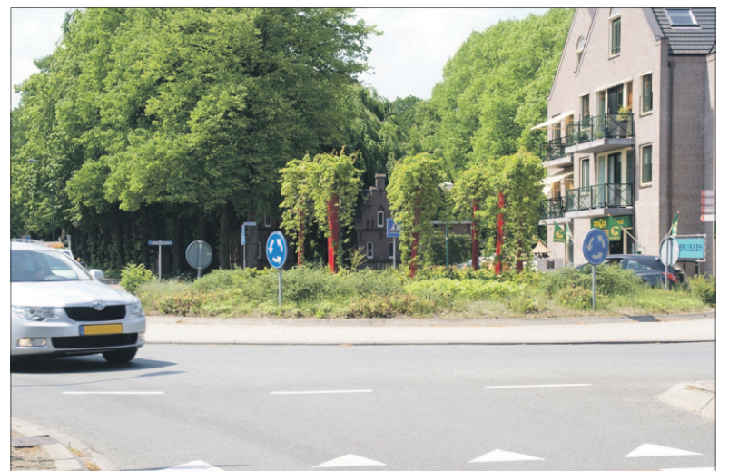
● De rotonde tussen de Steenhoffstraat en de Dalweg kan nu geadopteerd worden. Lokale ondernemers krijgen de kans om de rotonde in te richten en te onderhouden. Foto: Soester Courant
