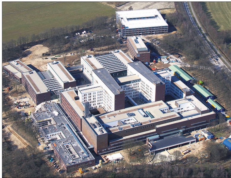
● De huidige stand van zaken bij de nieuwbouw van Meander Medisch Centrum, gezien vanuit de lucht. Foto: Jan van Uffelen/Aviaton
