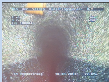
Inspectie: afvoer in oude riool
