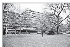
Energie label: B
