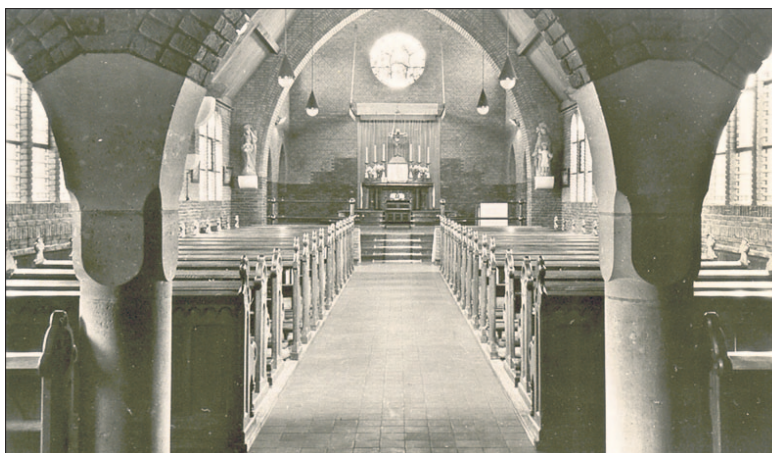
• Het vroegere interieur van het slotklooster Cenakel, onderdeel van de rondleiding door de werkgroep Soesterberg van de Historische Vereniging.
