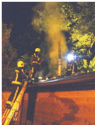
● De brandweer bezig met het verwijderen van een deel van het dak rond de schoorsteen van de sauna.
