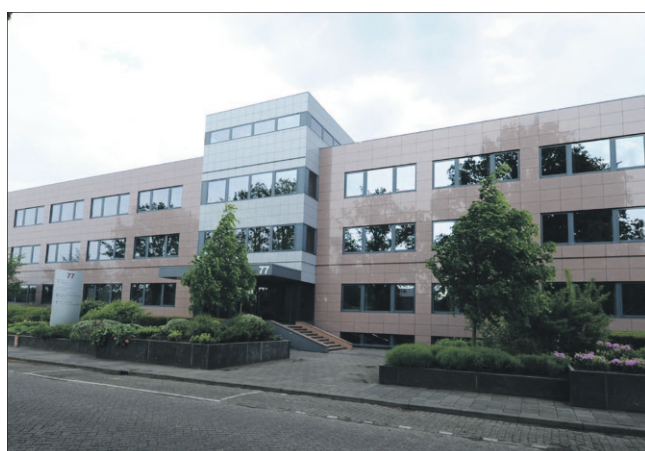
Het ruime en sfeervolle pand aan de Lange Brinkweg 77 in Soest.
