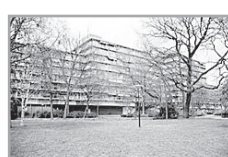
Energie label: B
