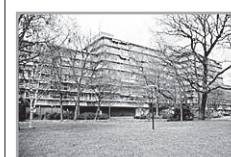
Energie-label: B W. Beckmanstraat 67
