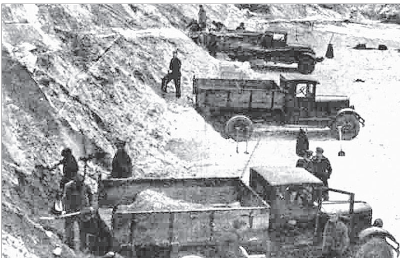
● Met vrachtwagens tegelijk werden de duinen afgegraven voor het versterken van de Grebbelinie. Foto: archief Eempers
