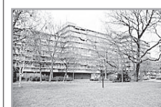
Energie label: B W. Beckmanstraat 419
