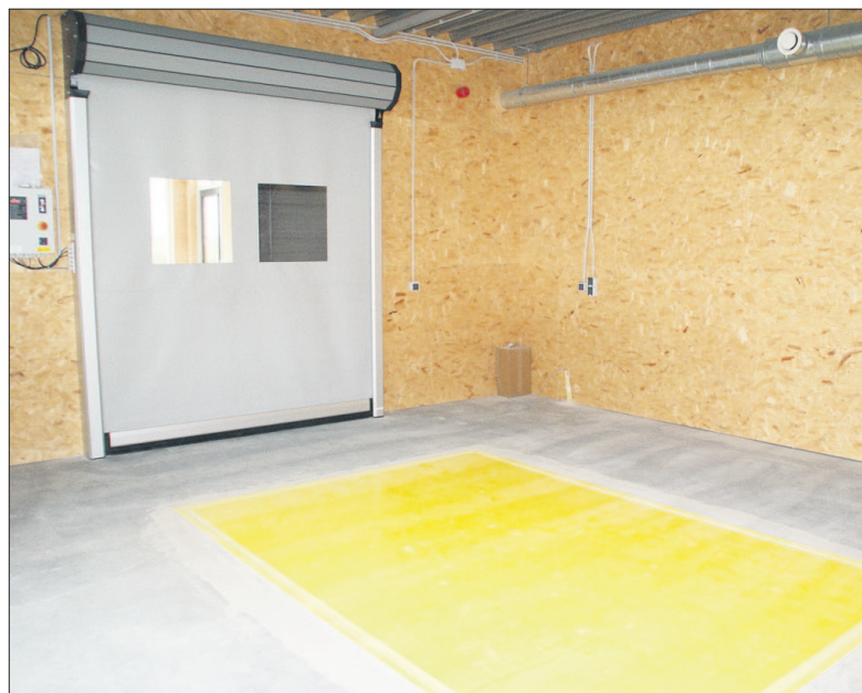
• Alle binnengebrachte spullen worden gewogen op deze geïntegreerde weegvloer.
