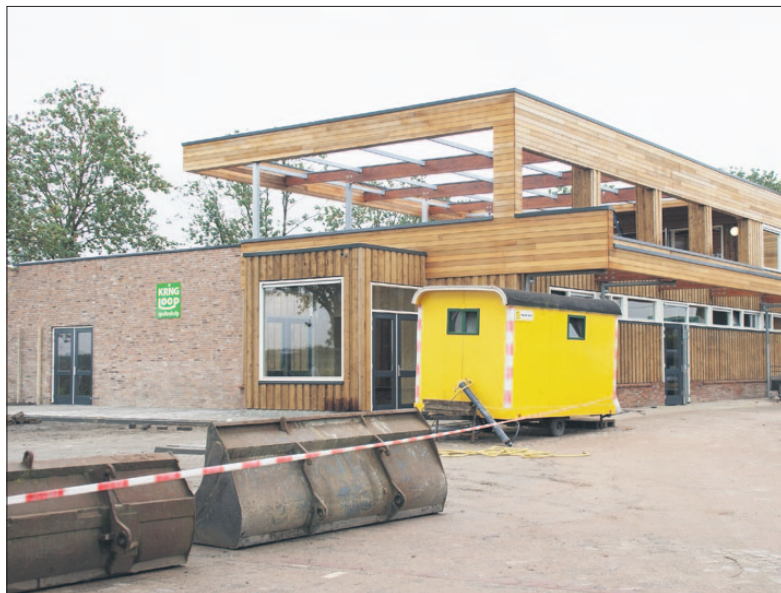
• Voor de uitbreiding van Kringloopcentrum Spullenhulp is ruim 700 vierkante meter aan Europees houten gevelbekleding gebruikt. Foto: Soester Courant
