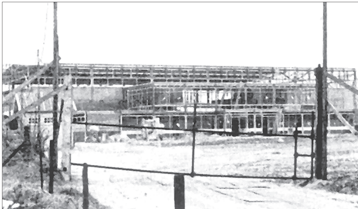
● Sporthal Beukendal tijdens de aanbouw, in 1969. Niet noodzakelijk, wel nuttig volgens het ICS-rapport.
