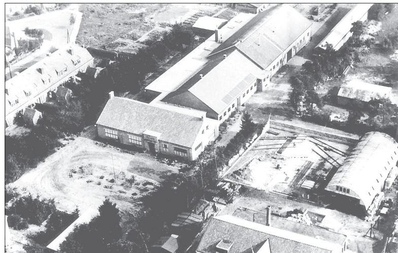
• Luchtfoto met de gebouwen in het midden van Tempo, rechtsonder de garage van Leguit/Speek & Muller.
