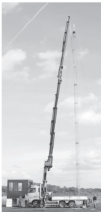
De zendmast wordt geplaatst voor de uitzendingen van RadioBaken vanaf de vliegbasis Soesterberg. Rechts een van de huisjes waarin belangstellenden de uitzending kunnen beluisteren.
