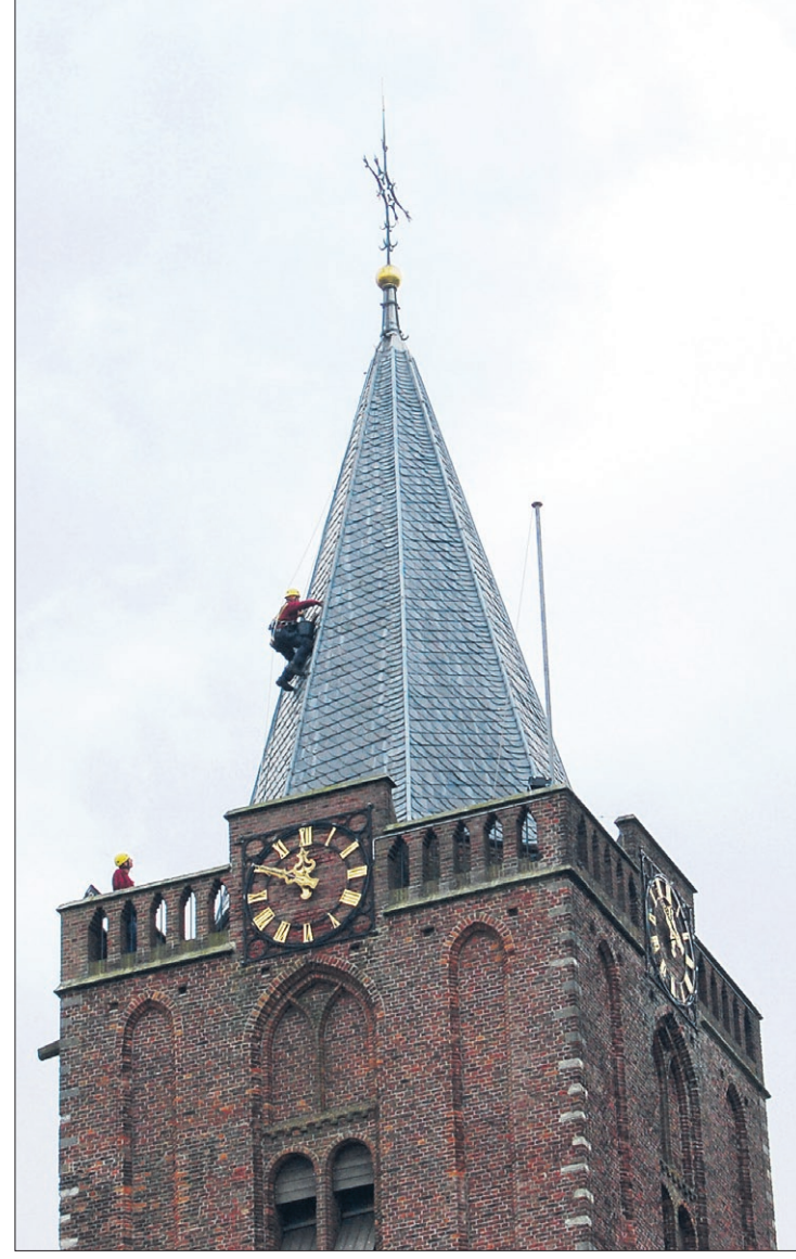
Het was geen parachutist na een mislukte landing, de man die maandag aan de torenspits van de Oude Kerk hing, maar een leiddekker. Op ruim veertig meter hoogte was hij, veilig gezekeerd, met een collega op de torentrans die de leien aangaf, bezig met onderhoud aan de spits door het vervangen van leien die daarvoor in aanmerking kwamen. Het leverde deze bijzondere opname op. Foto: Eempers.
