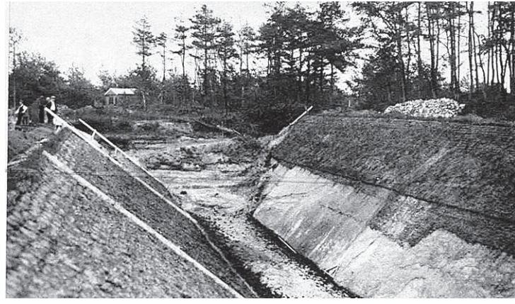
● Aanleg van open zandfilters bij het eerste pompstation in Soestduinen in 1883.
