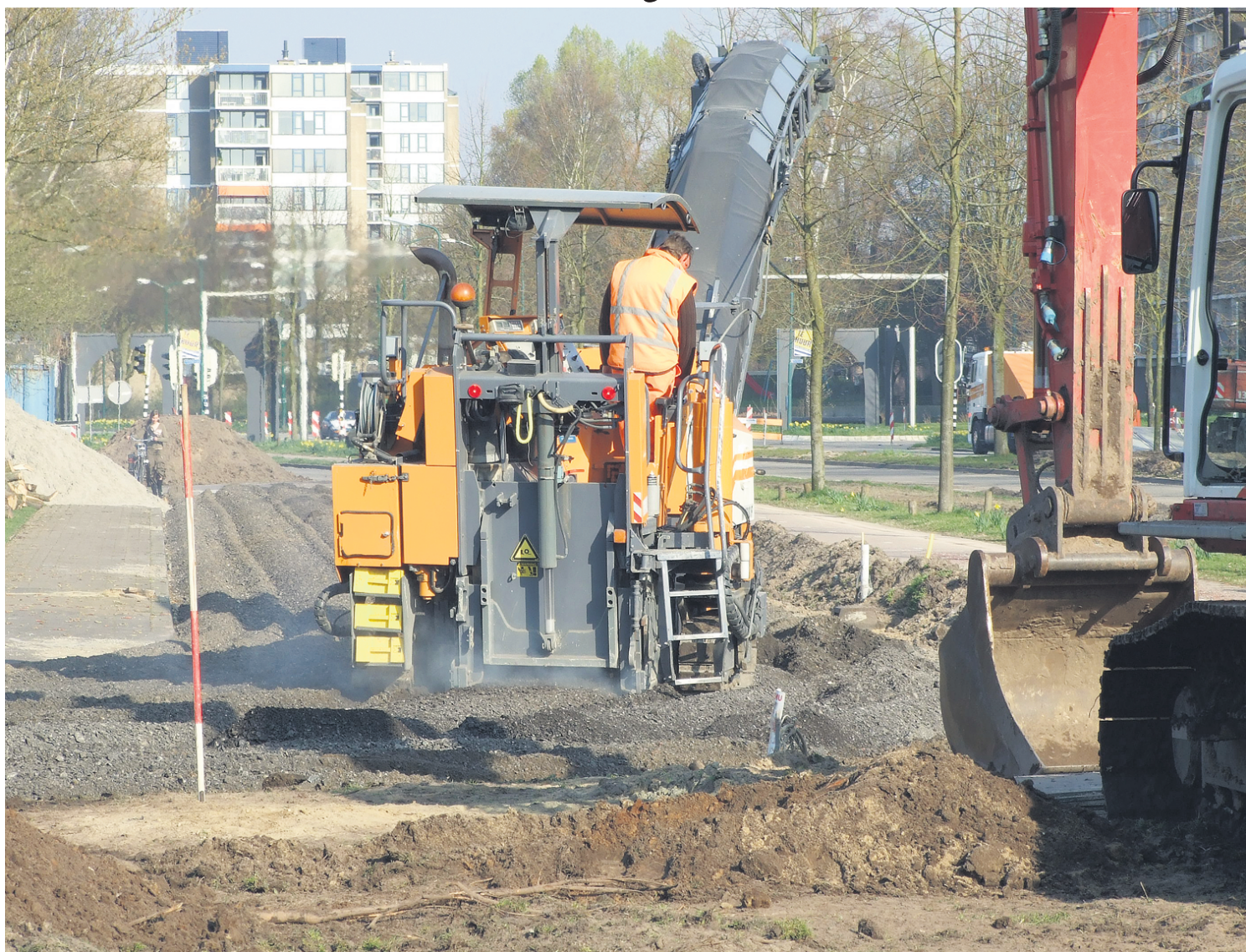
● Sinds maandag is het omrijden geblazen voor veel weggebruikers. De Koningsweg, een van de belangrijkste verkeersaders van Soest, is afgesloten ter hoogte van de Dorpssteek, omdat daar een rotonde wordt aangelegd. Tot en met april zal het verkeer de aangegeven alternatieve routes moeten volgen. Extra obstakel voor gemotoriseerde voertuigen zijn de werkzaamheden op de Biltseweg. Bij 't Spiehuys wordt de rijbaan verbreed en daarom kan er tot en met 13 april tussen 20:00 en 06:00 uur geen auto, vrachtwagen of motor langs. Goed nieuws voor de degenen die wel van een ommeetje houden. In mei wordt begonnen met de realisatie van nog een rotonde op de Koningsweg, dan bij de aansluiting met de Dalweg. Ook die werkzaamheden zullen circa vijf weken in beslag nemen. Foto: Soester Courant
